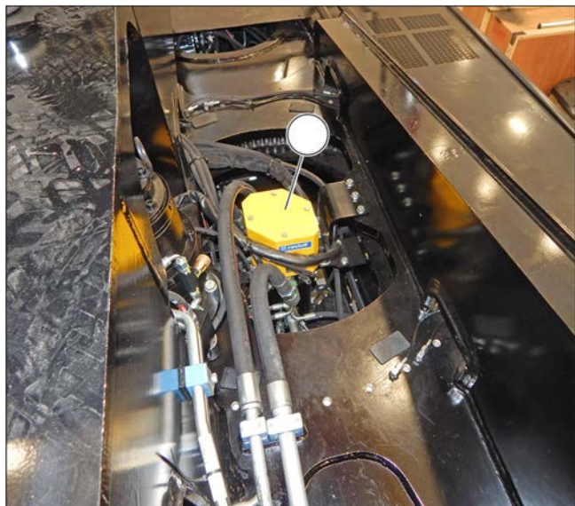
Figura 208: Comprobación y limpieza de los anillos transmisores del colector eléctrico rotativo
